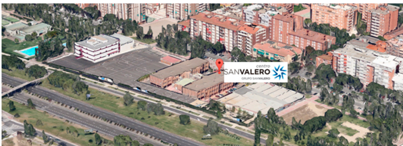
Ilustración 1. Vista aérea del Centro en la Calle Violeta Parra 9, 50015, Zaragoza
