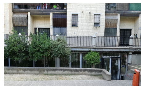
Ilustración 3. Acceso al CSL de la calle Jusepillo Olleta.
