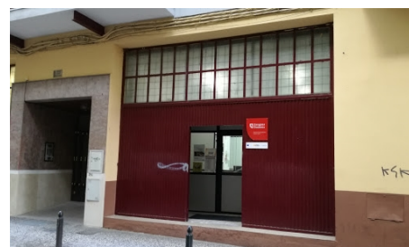
Ilustración 5. Acceso al CSL de la calle Rebojería.
